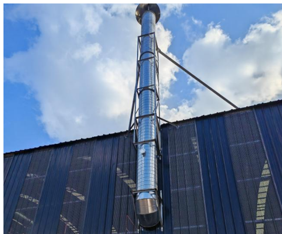
1#储煤棚布袋除尘器 + 排气筒
