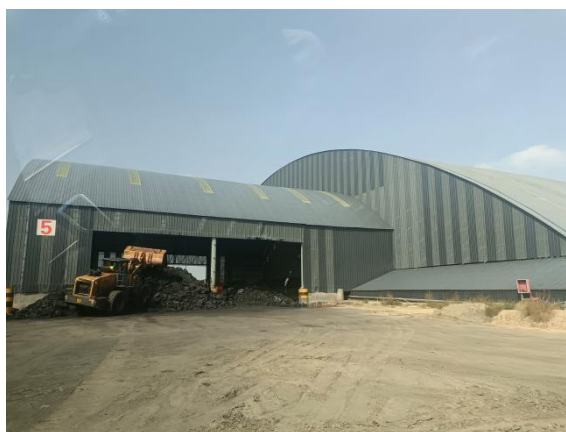
5#全封闭卸煤棚
