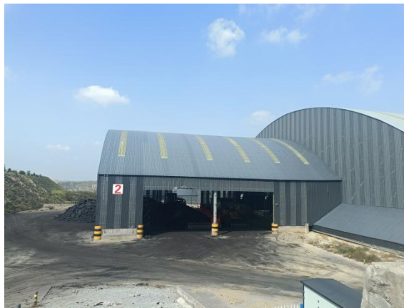
2#全封闭卸煤棚
