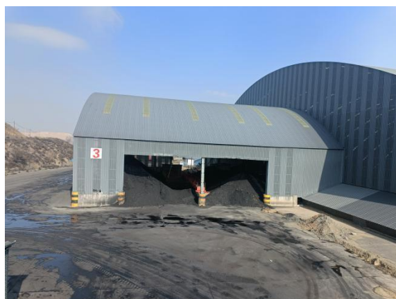
3#全封闭卸煤棚
