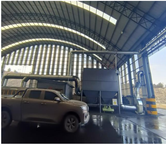
2#储煤棚布袋除尘器 + 排气筒
