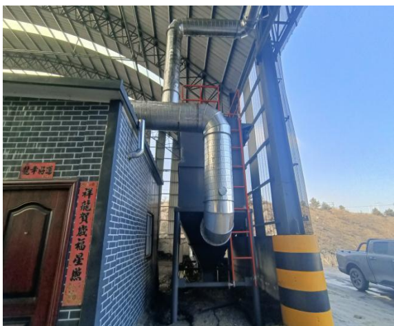
1#储煤棚布袋除尘器 + 排气筒
