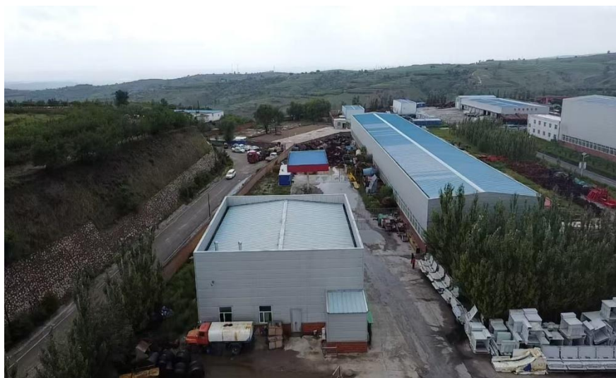
锅炉房西侧现状
