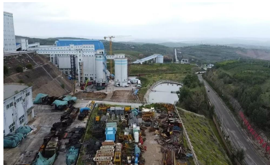
锅炉东侧现状
