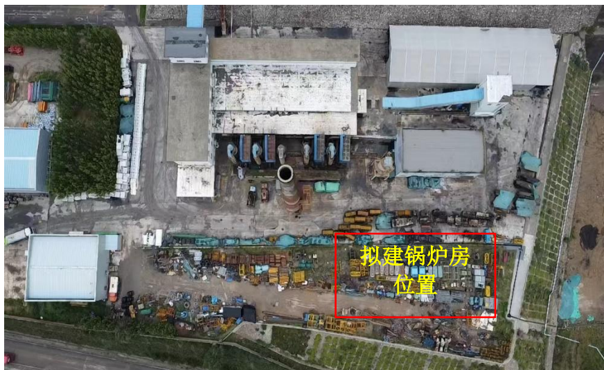
现有锅炉房现状
