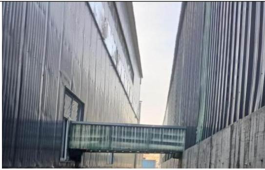
末精煤输煤栈桥皮
