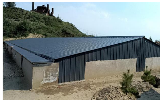
雨水收集池（后）
